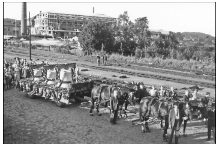
Transport der neuen drei Stahlglocken vom Bahnhof zur Kirche, 1955. Foto © Stadt Lütjenburg
