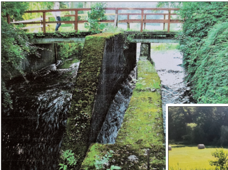
Durch den Bau einer Sohlgleite konnte die Gewässerdurchgängigkeit der Kossau in Höhe der „Rantzauer Papierfabrik“ wieder hergestellt werden.
